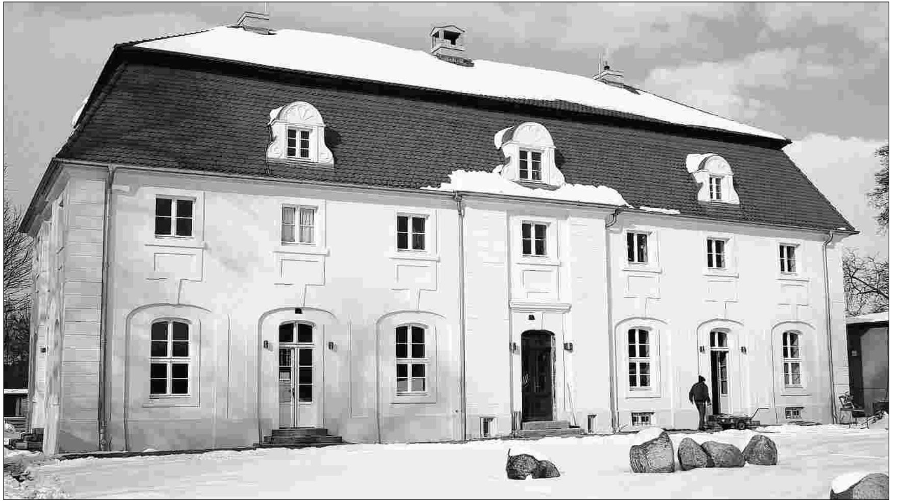
Liebevoll saniert: Im Inspektorenhaus befinden sich jetzt Hotelzimmer, Küche und Restaurant. Die Gäste genießen einen Ausblick auf den See.
