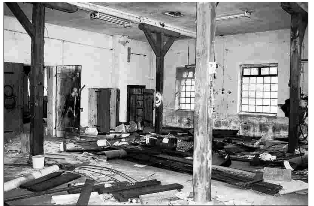
Chaotischer Zustand 2005: So fand der neue Eigentümer die alten Technikhallen auf dem Gelände vor.
